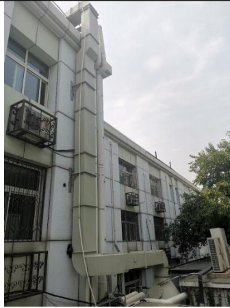
废气排放管道和房顶排气口
